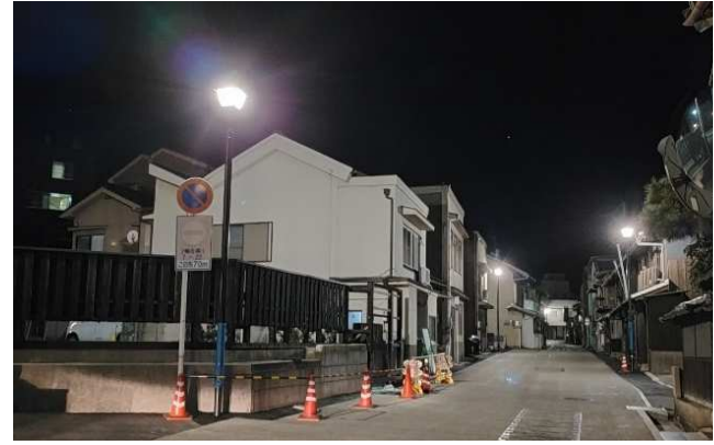
写真②：無電柱化区間（鞆永線1工区）照明工事
