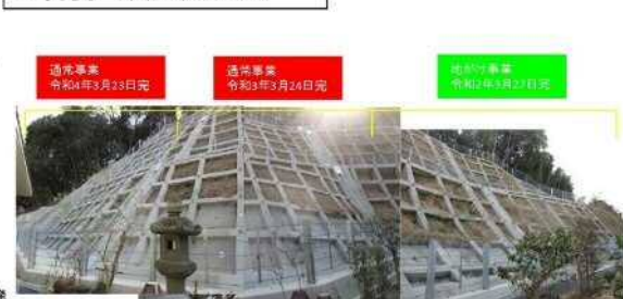
工事完了（令和4年3月23日）
