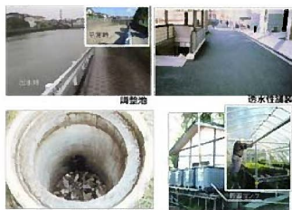
雨水貯留浸透施設の例
