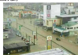
(平成30年7月 福山市蔵王排水区)
