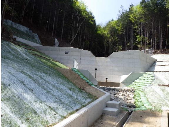
県：治山激甚災害対策特別緊急事業 岩鼻地区 (安佐北区白木町)
