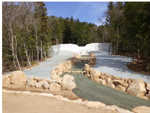
県：治山激甚災害対策特別緊急事業 浄泉比良地区 (東広島市豊栄町)
