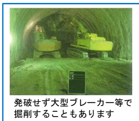
機械掘削の場合
