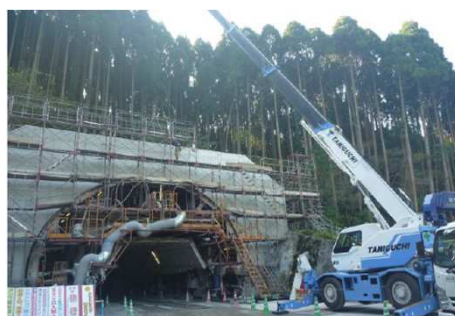
センターセット後、足場組立状況
