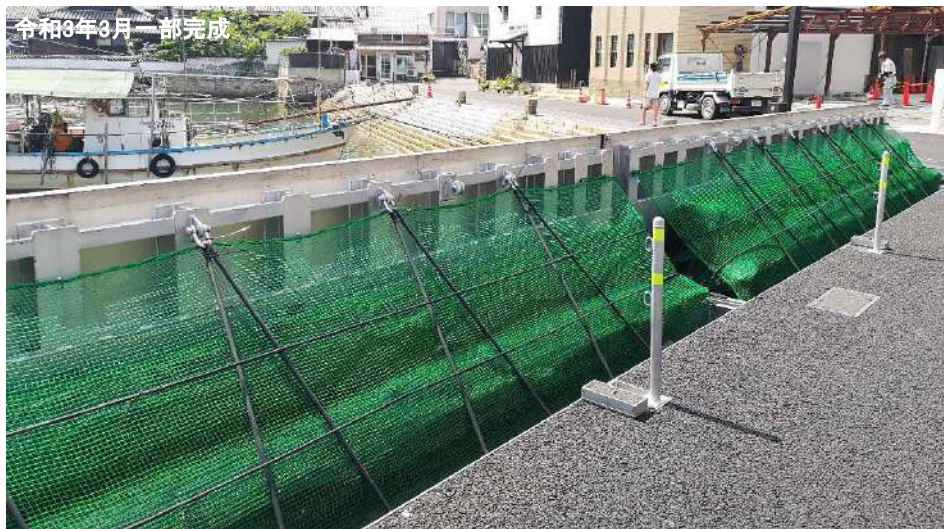
西町地区（起伏式ゲート、雁木復元）
