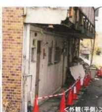
外壁、手すりが崩落した事例
