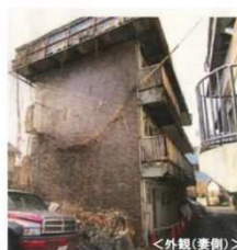
外壁、手すりが崩落した事例
