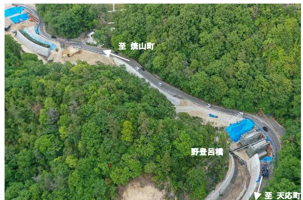
写真②橋梁下部工施工状況
