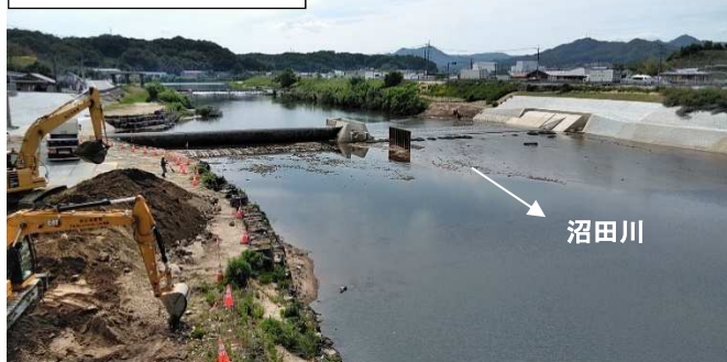
①沼田川（堰改築状況）
