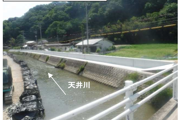
②天井川（擁壁工施工状況）
