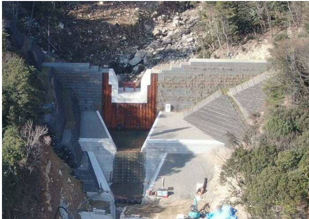
県：砂防激甚災害対策特別緊急事業 石ヶ鼻川 (呉市安浦町)
