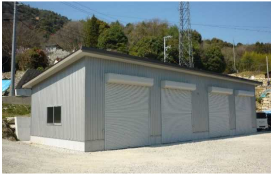
農業用倉庫の復旧状況 (呉市)
