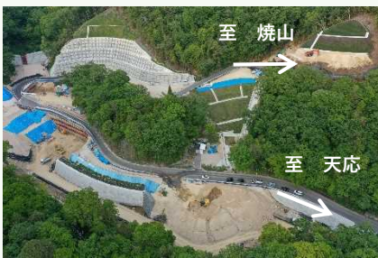
主要地方道 呉環状線 道路災害関連事業 (呉市天応町～焼山町地内)
