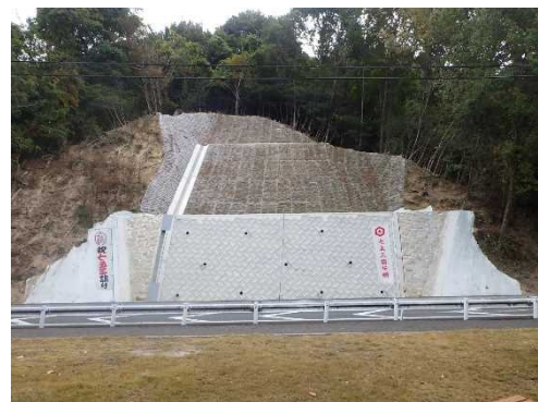
(主) 東海田広島線（安芸郡府中町）
