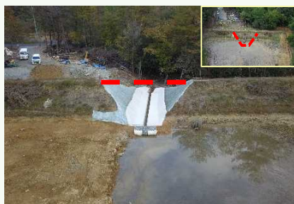
ため池の廃止工事状況 (安芸高田市)
