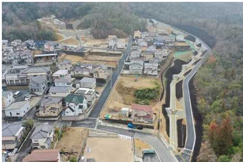
砂防指定地内河川 二河川支川21, 21隣 再度災害防止事業 (熊野町川角)
