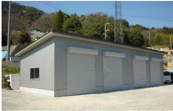
農業用倉庫の復旧状況 (呉市)
