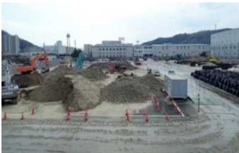
二次仮置場（坂町）処理中
