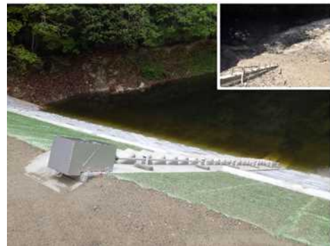
ため池の復旧工事状況 (尾道市)
