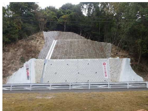
(主) 東海田広島線（安芸郡府中町）
