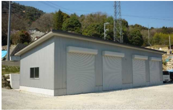
農業用倉庫の復旧状況 (呉市)
