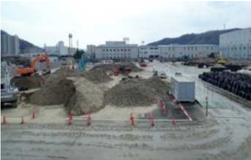
二次仮置場（坂町）処理中
