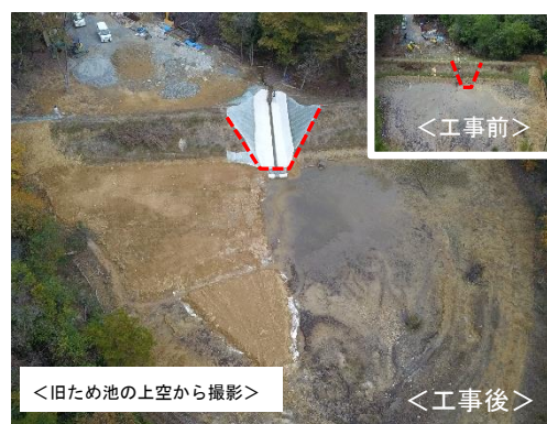
ため池廃止工事（安芸高田市）
