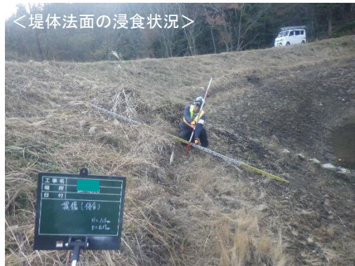
劣化診断の実施状況（安芸高田市）
