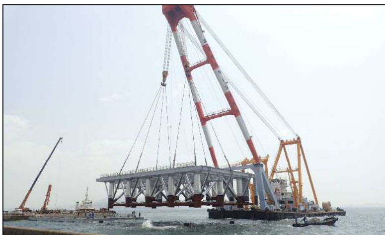
福山港（箕沖地区）
