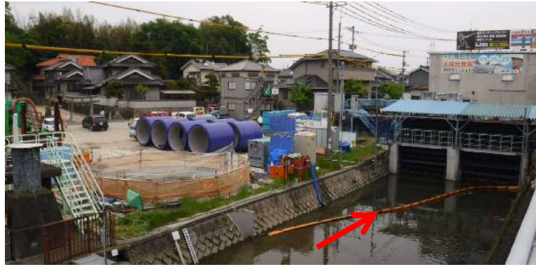
(仮称) 福川排水機場 (福山市神島町)
