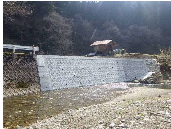
高光川 河川災害復旧工事 (神石高原町, 令和3年3月完成)
