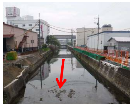
中流域工事 (福山市引野町)
