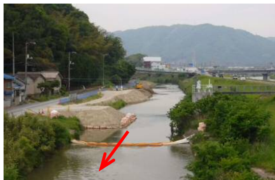
用水管渠敷設工事
