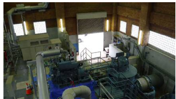
古市排水ポンプ場
