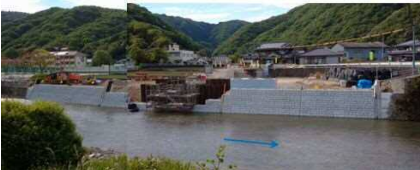
（新）僧殿橋左岸橋台及び樋門工事
