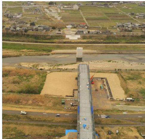
施工状況（福山市駅家町）
