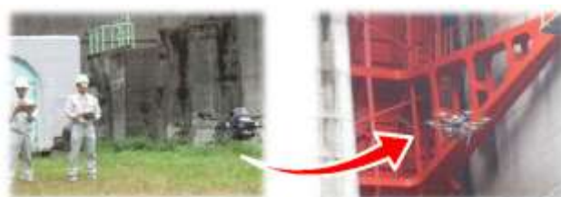
ドローンを活用した施設点検
