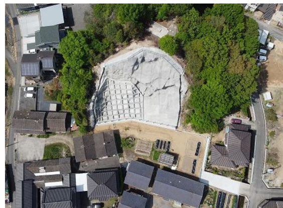
引野町626地区 災害関連緊急 急傾斜地崩壊対策工事 (福山市引野町 令和4年3月完成)
