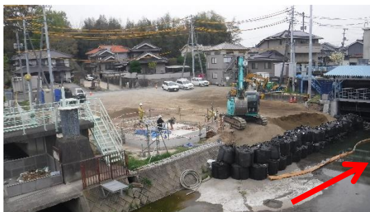
(仮称) 福川排水機場（福山市神島町）
