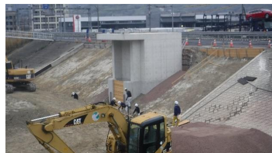
吐出樋門（瀬戸川）
