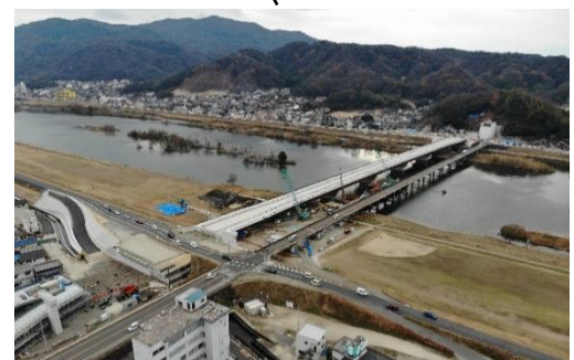
施工状況 (芦田川渡河部)
