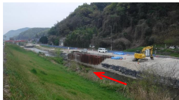
用水管渠敷設工事
