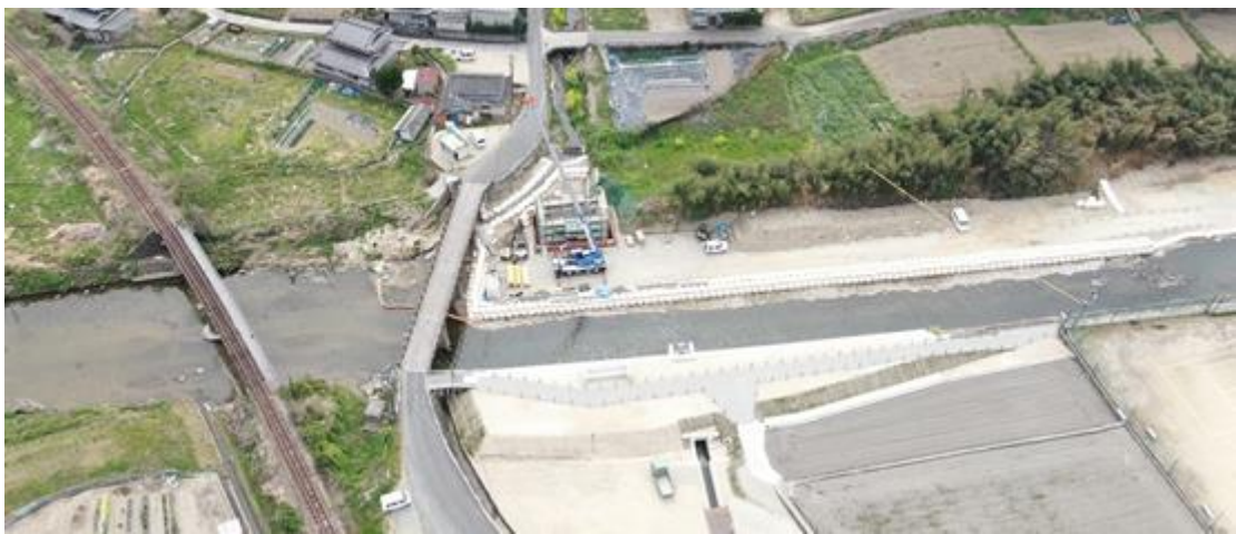
(新) 備前橋左岸橋台及び樋門工事
