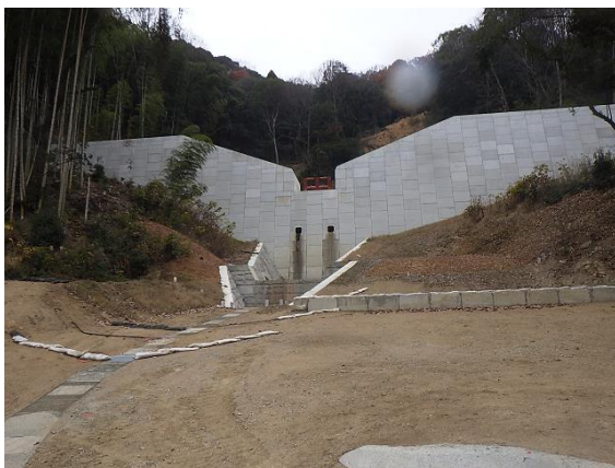
荻之尾川隣 災害関連緊急砂防工事 (福山市神村町 令和 3 年 12 月完成)
