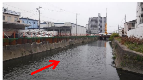
中流域工事（福山市引野町）
