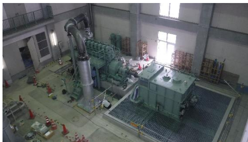
ポンプ増設工事（手城川排水機場内）
