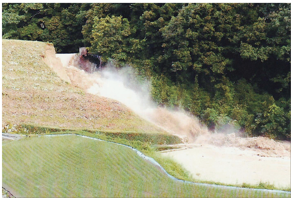
平成28年6月23日に発生したため池の決壊状況（福山市）
