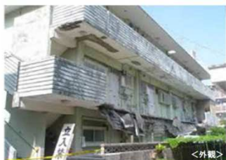
<外観> マンションの2階廊下部分が崩落した事例
