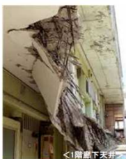
<外観> マンションの2階廊下部分が崩落した事例
