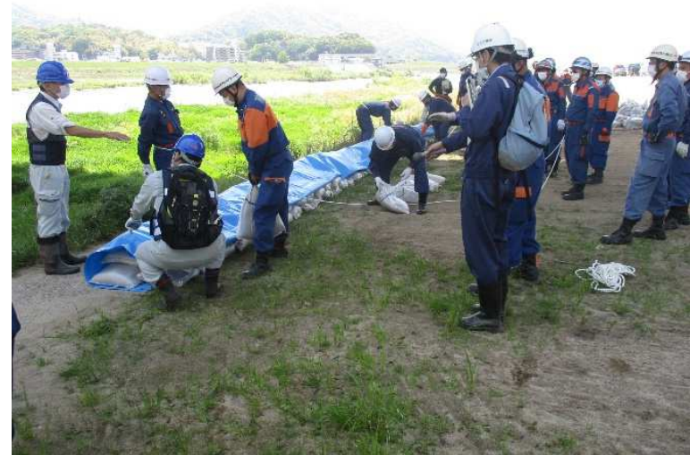
改良積土のう工
