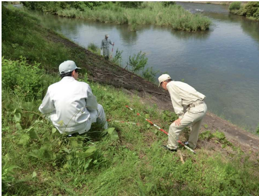
堤防点検の様子（馬洗川）
