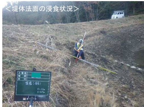
劣化診断の実施状況（安芸高田市）
