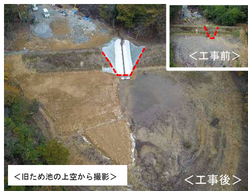
ため池廃止工事（安芸高田市）
