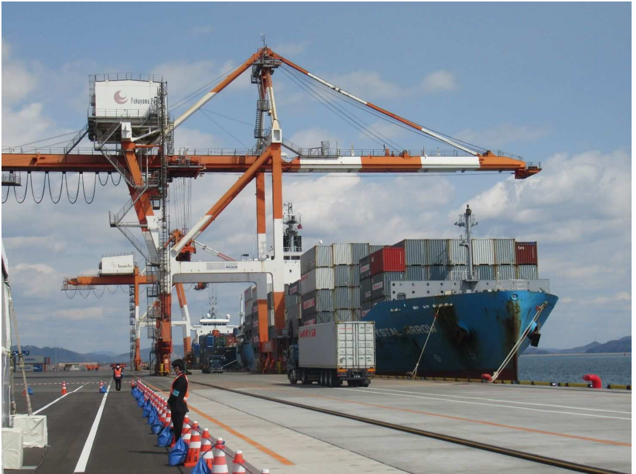
福山港箕沖地区岸壁（R 4.3 供用開始）
