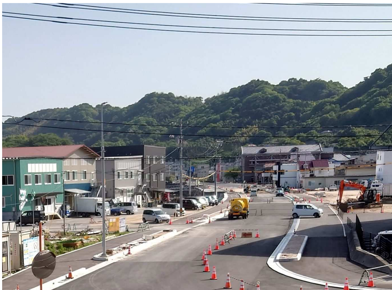
国道487号（小用バイパス）道路改良事業（江田島市江田島町小用）
