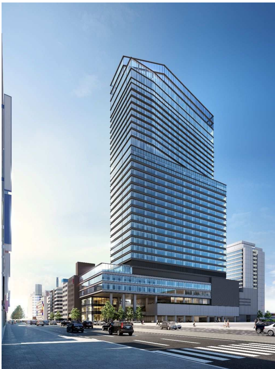
基町相生通地区第一種市街地再開発事業（完成イメージ図）
