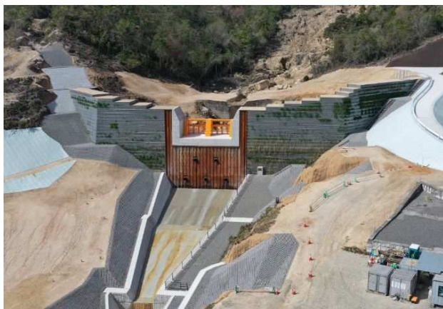
「平成30年7月豪雨災害 砂防・治山施設整備計画」における緊急事業が概ね完了（水尻川：呉市安浦町三津口）
