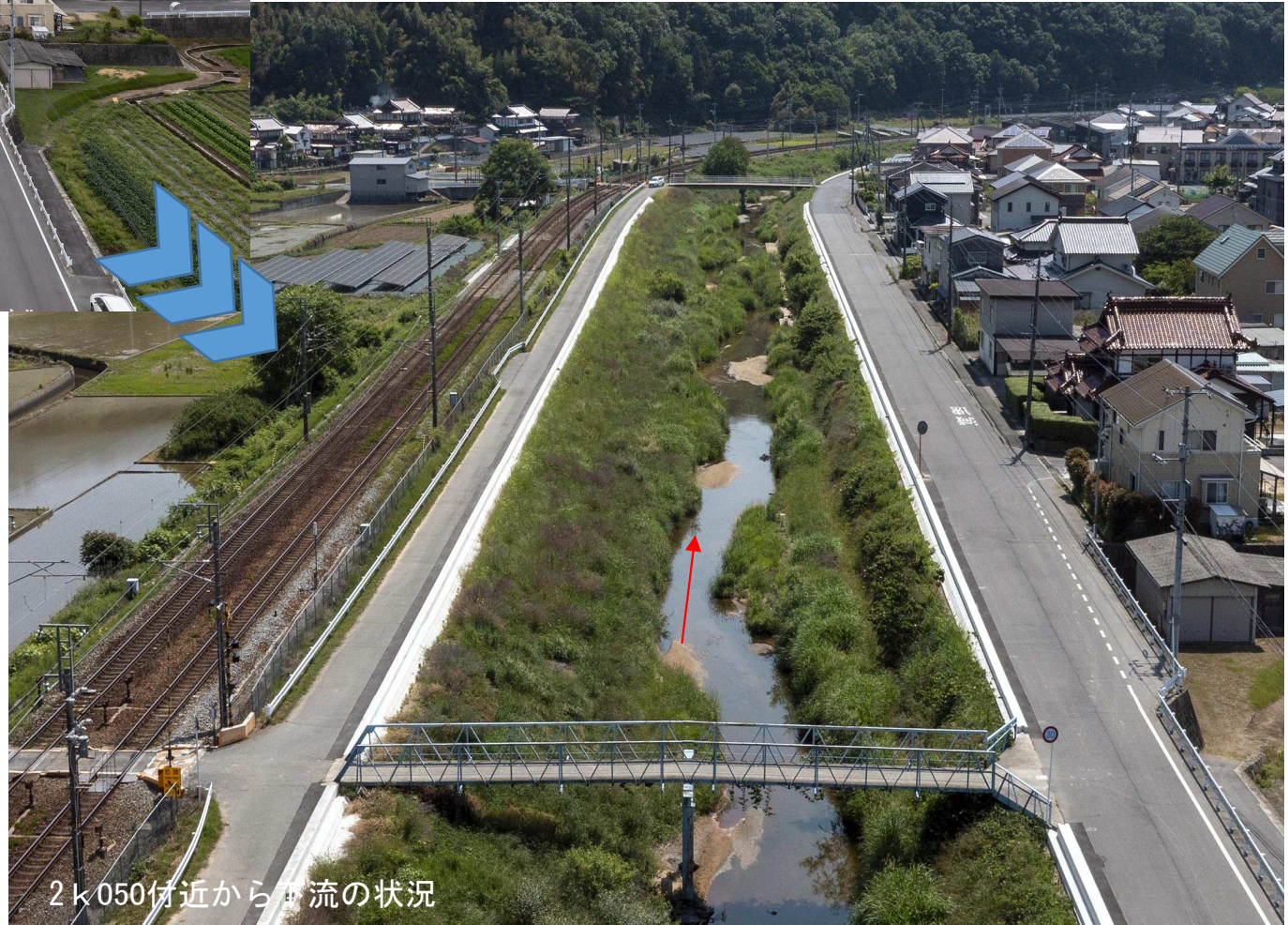
築堤工事完成 (令和4年5月撮影)
