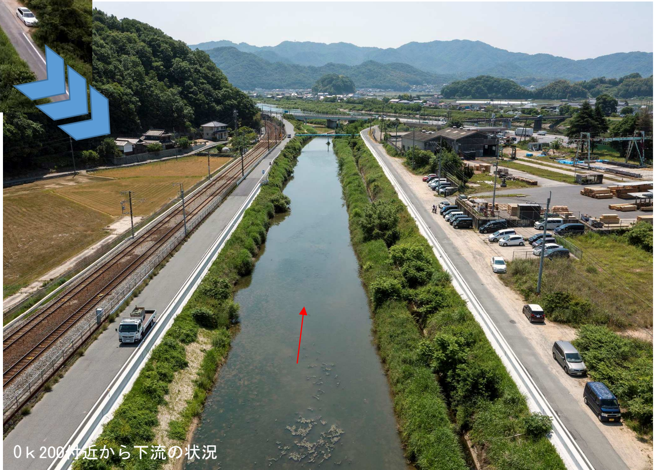
築堤工事完成 (令和4年5月撮影)
