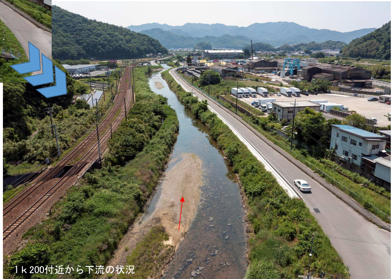
築堤工事完成 (令和4年5月撮影)
