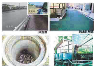
雨水貯留浸透施設の例
