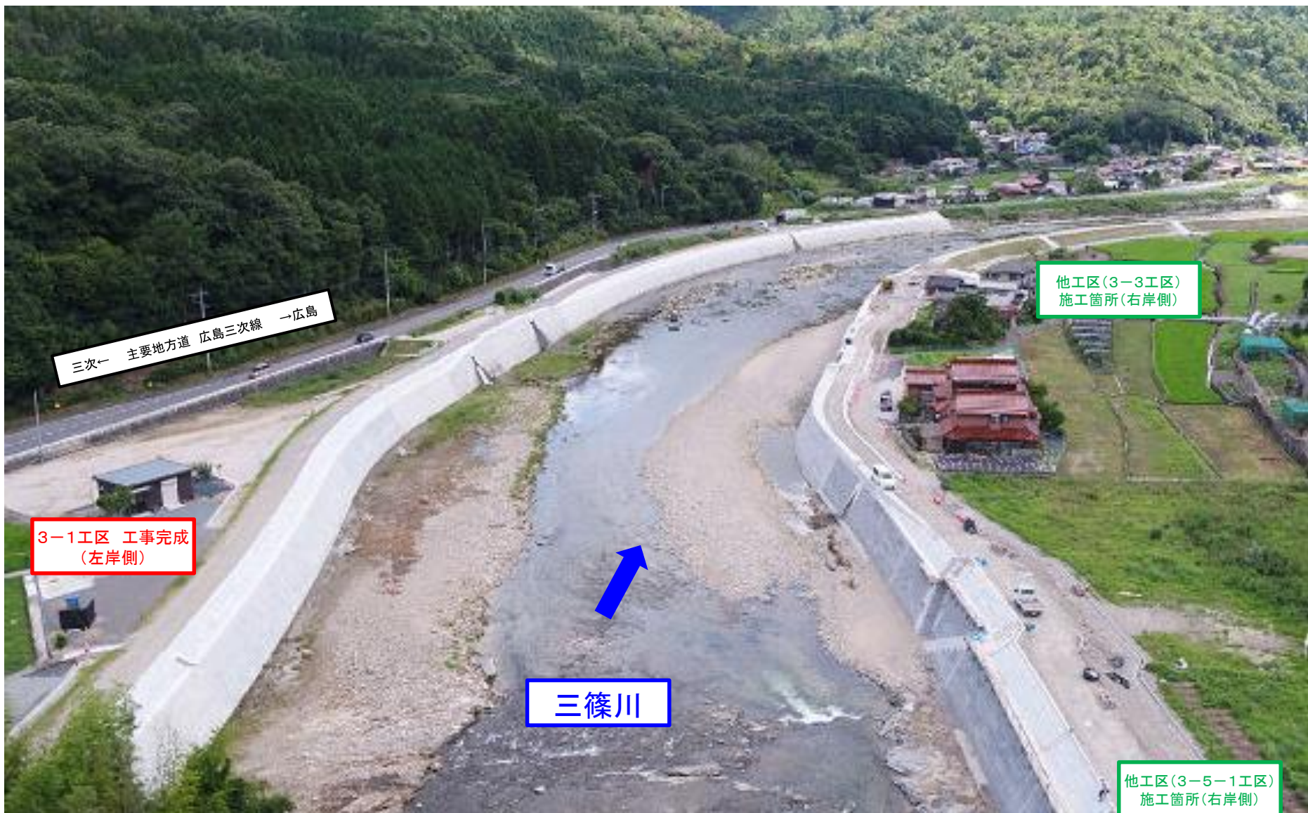
写真③（施工箇所付近全景）
