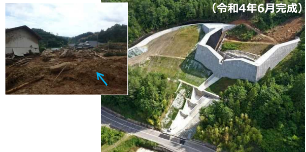
山岡西川隣 砂防激甚災害対策特別緊急事業(三原市)
