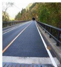
はく離・わだち・ポットホールなどの損傷なし
