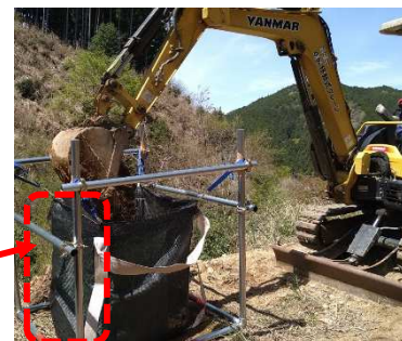
植生 シート部
