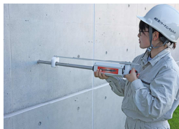
写真-2 計測状況
