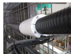
写真-3 インナーケーブル設置状況
