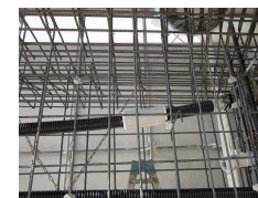
写真-3 インナーケーブル設置状況
