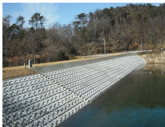
改修後のため池
