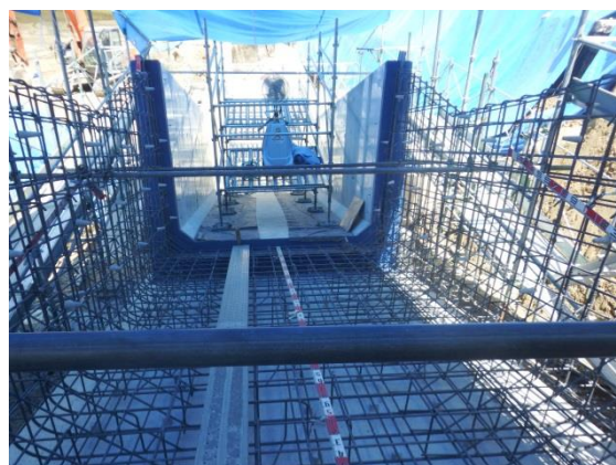
洪水吐の工事
