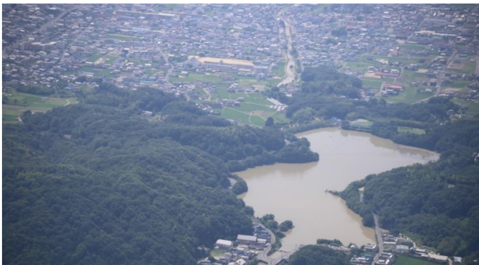
写真 I—10 都市化が進み受益地が減少しているため池
