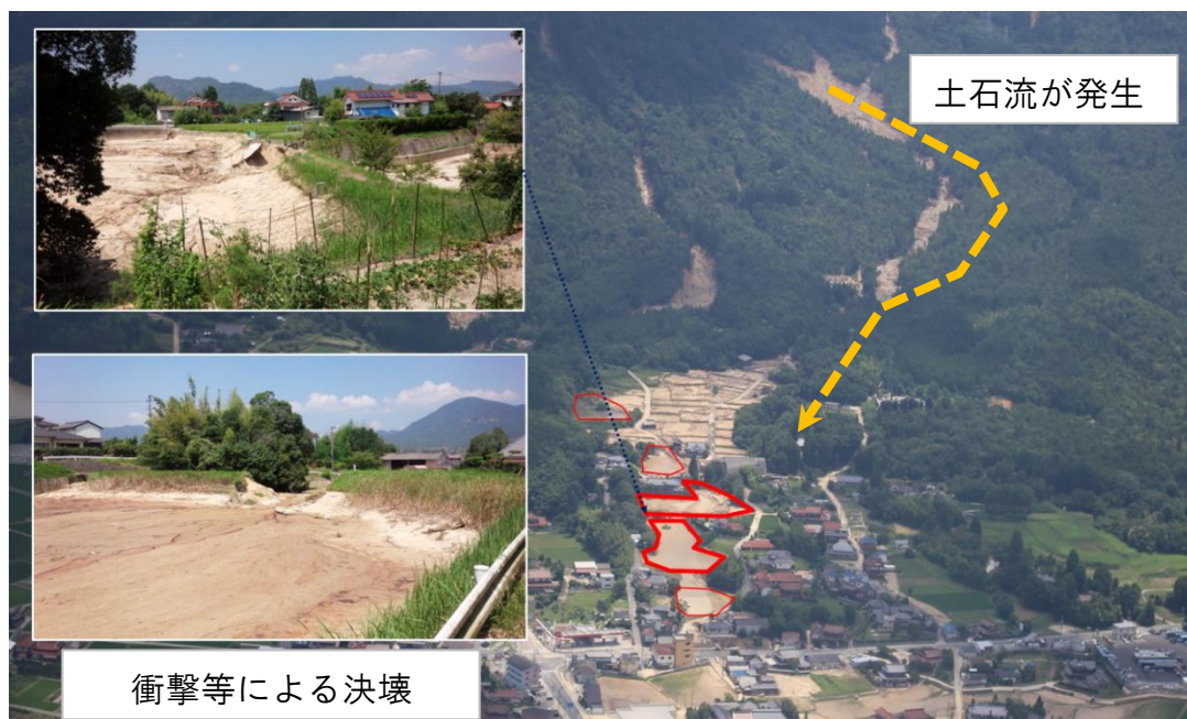
写真 I - 7 土砂等の流入により決壊したため池
