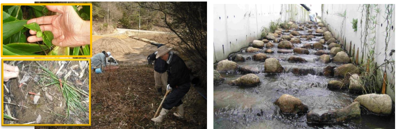
写真VI-1 環境への配慮の事例 (左：貴重な植物の移植，右：魚などの生息に配慮した環境配慮型水路)
