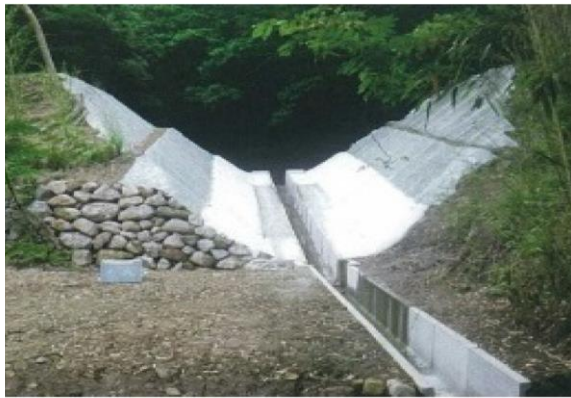
写真Ⅳ-4 廃止工事（掘割） （農林水産省資料より）
