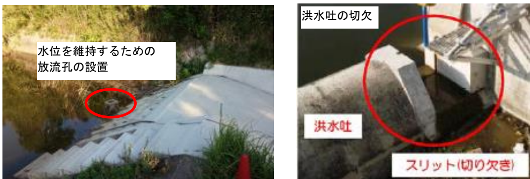
写真IV-2 低水位管理を行うための簡易な改修の例（出典：農林水産省）
