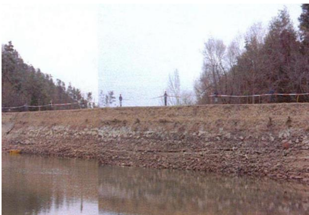
改修前のため池
