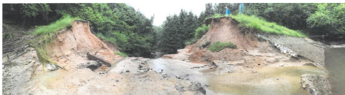
写真 I - 4 浸透による破壊が発生し決壊したため池
