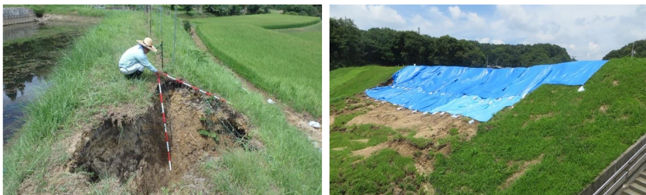
写真 I - 3 ため池の緊急点検及び応急措置の状況
