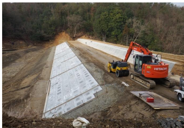
堤体の締め固め
