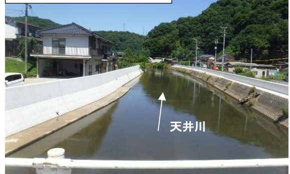
②天井川（擁壁工施工状況）
