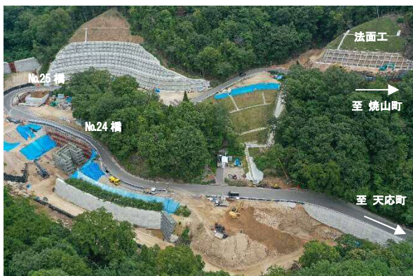
写真①法面工，橋梁上部・下部工施工状況
