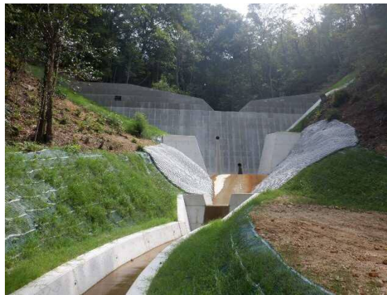
県：治山激甚災害対策特別緊急事業 堀越地区 (呉市焼山町)
