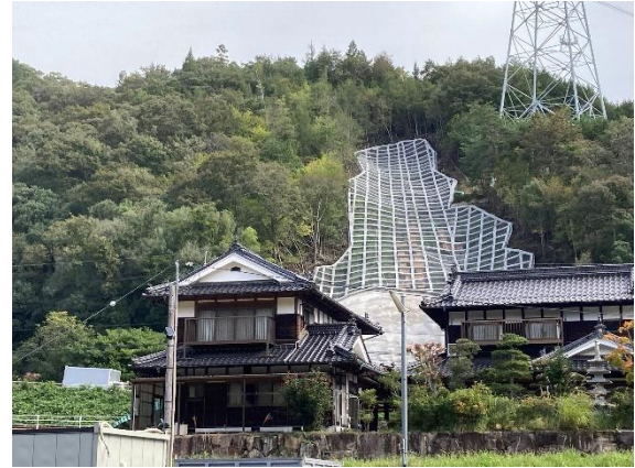
県：治山激甚災害対策特別緊急事業 平山地区 (東広島市福富町)
