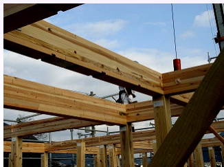
建築現場での使用事例 横架材（梁・桁）
