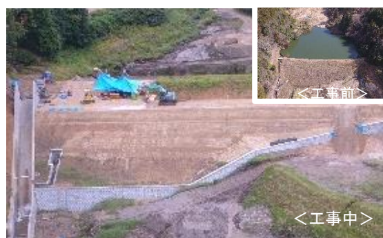
ため池の補強工事状況（庄原市） (堤の再構築と水路の拡張)
