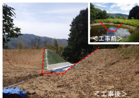
ため池の廃止工事状況（安芸高田市） (堤体を開削し水路を設置)
