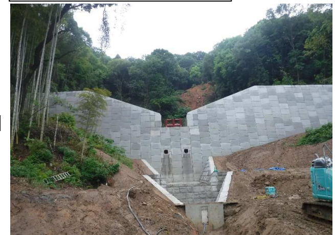
工事完了（令和3年5月6日）
