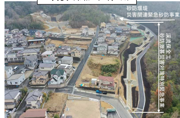
工事完了(令和4年3月8日)
