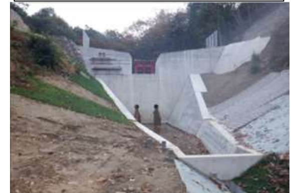
工事完了（令和2年12月21日）
