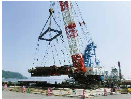
港湾工事 (木江港)
