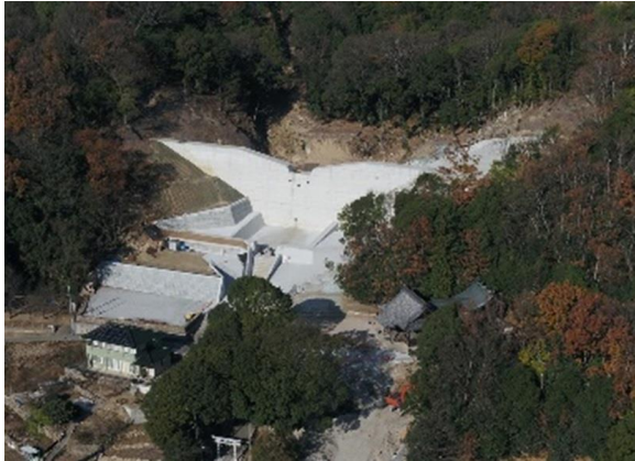
県：砂防激甚災害対策特別緊急事業 楠木谷川 (海田町畝)
