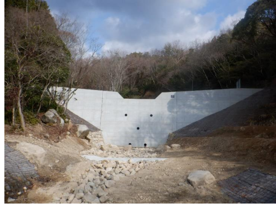
県：治山激甚災害対策特別緊急事業 才野谷1地区 (呉市川尻町)
