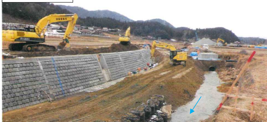
①護岸工施工状況
