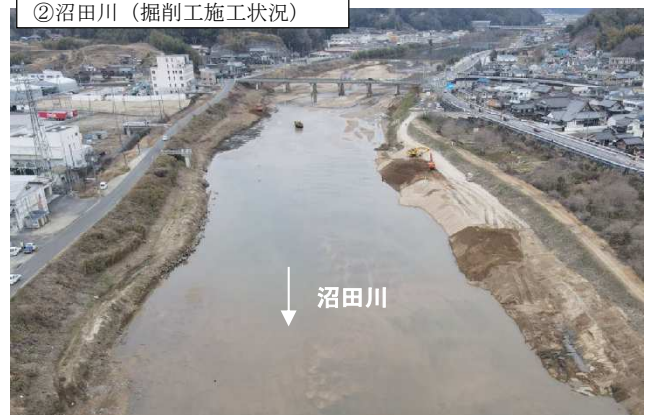
②沼田川（掘削工施工状況）
