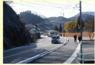
(主) 大崎上島循環線 大田工区 (豊田郡大崎上島町) 【R2 部分完成】
