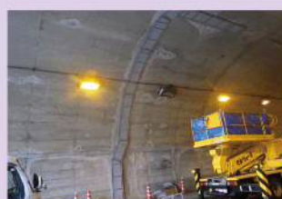
【トンネル補修】 国道 184 号 木門田トンネル (尾道市木ノ庄町) 【R2 完了】
