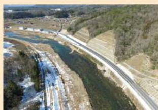
(主) 浜田八重可部線 川井工区 (山県郡北広島町) 【H28 完成】
