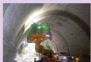
【トンネル補修】 国道 191 号 安野トンネル (山県郡安芸太田町) 【R1 完了】
