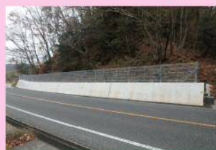
【法面对策】 国道182号 坂瀬川工区 (神石郡神石高原町) 【R1 完成】
