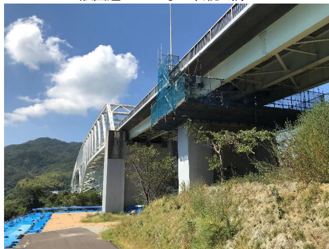
耐震補強施工状況（P 1 橋脚）
