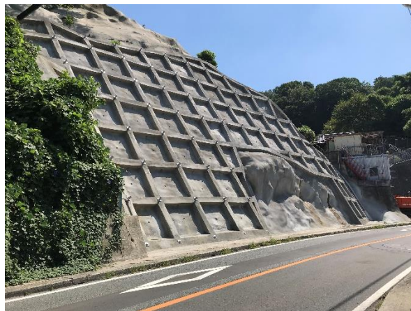
主要地方道音戸倉橋線 呉市音戸町
