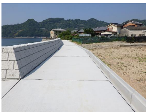
御手洗港（南堀）海岸保全施設整備事業
