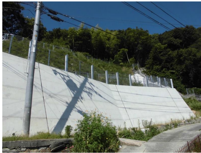
急傾斜地崩壊対策事業 北隠渡二丁目
