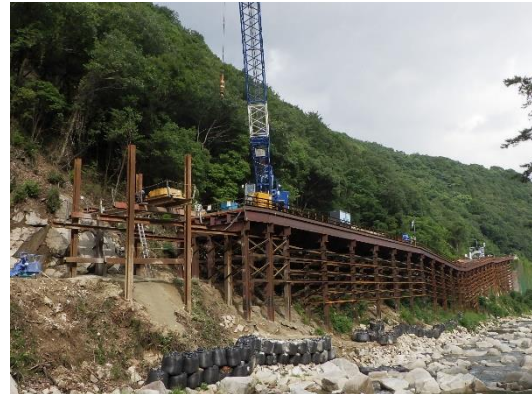
上二河地区の工事状況
