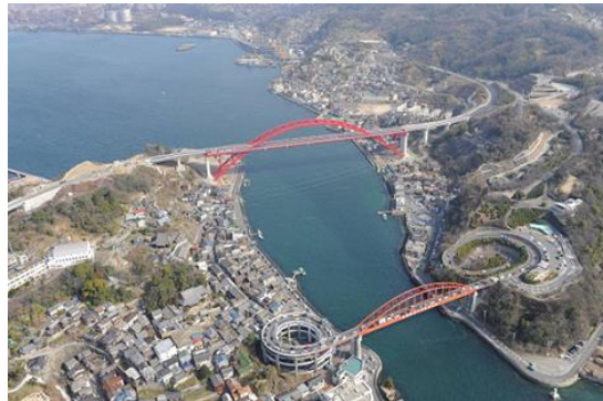
一般国道487号 警固屋音戸バイパス （第二音戸大橋（写真上方）と音戸大橋）
