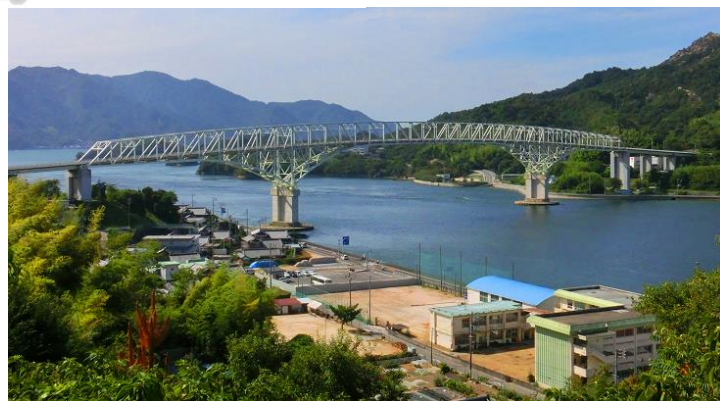
一般国道487号 早瀬大橋
