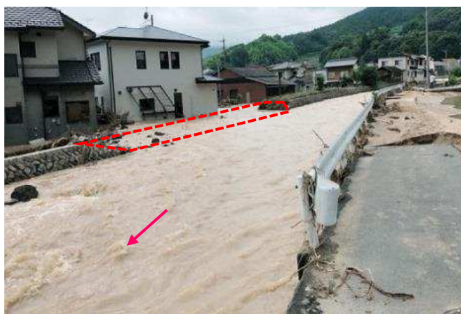
河川の破堤状況(野呂川水系中畑川)
