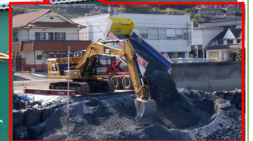
トンネルから発生する土砂(泥岩)が黒色のため、黒色の濁りが発生していますが、環境的に問題はありませぬ。
