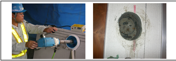
図1 掘削作業（左）と掘削後の穴（右）
