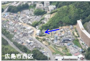
令和3年8月豪雨災害の被災状況
